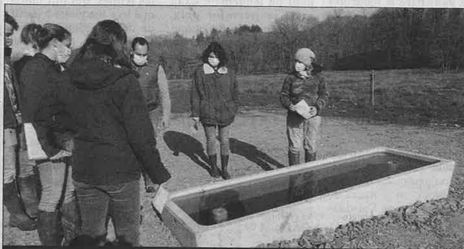
TRAVAUX. Les travaux d'aménagement d'abreuvoirs sur la Grande Briance sont achevés.
