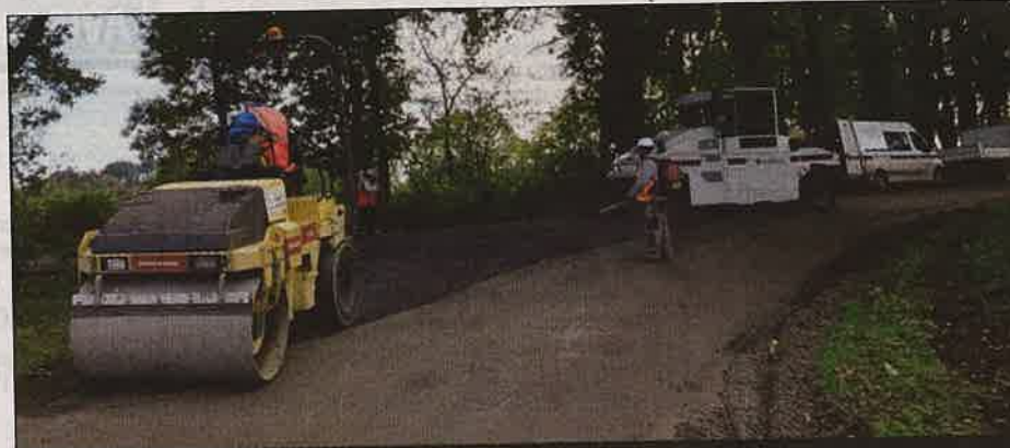
TRAVAUX. Le dernier raccordement de la route du Larcy à celle du Pouyol vient d'être réalisé.
