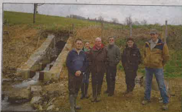
LA CHABASSIÈRE. L'aménagement de la passe à poissons a consisté à fractionner la chute totale en plusieurs petites chutes franchissables par les truites.
