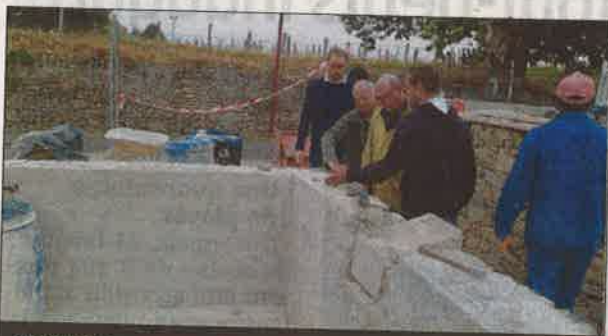
TRAVAUX. La restauration du lavoir est en phase terminale.
