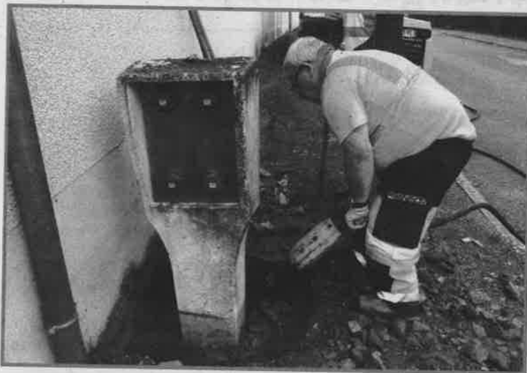
Travaux sur les bornes électriques rue du Rio-Poulard.
