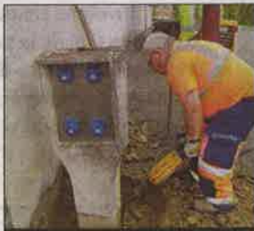
TRAVAUX. Bornes Rio-Poulard : les travaux ont commencé.
